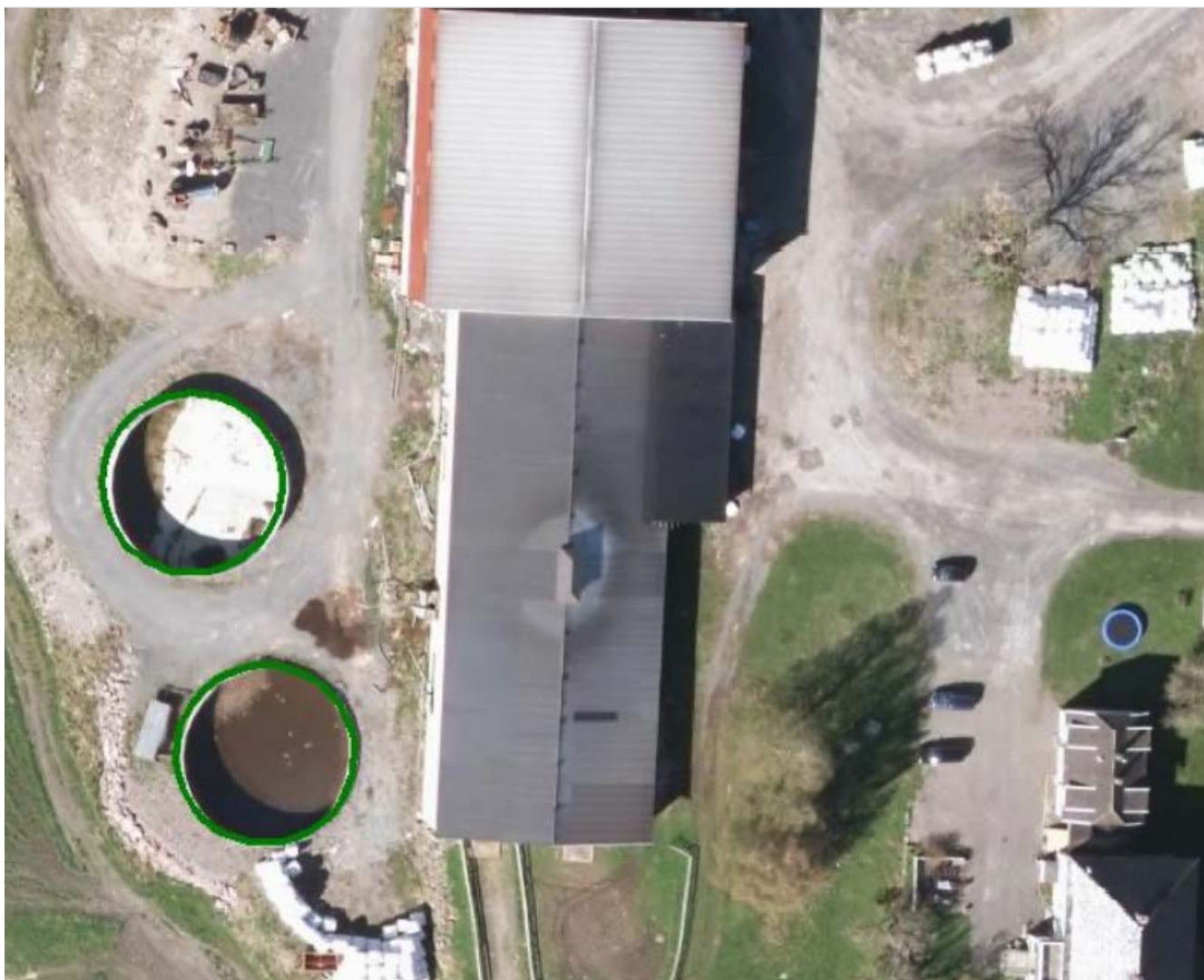
Figur 26. Eksempel på registrering av åpen gjødselkum som MurFrittstående
