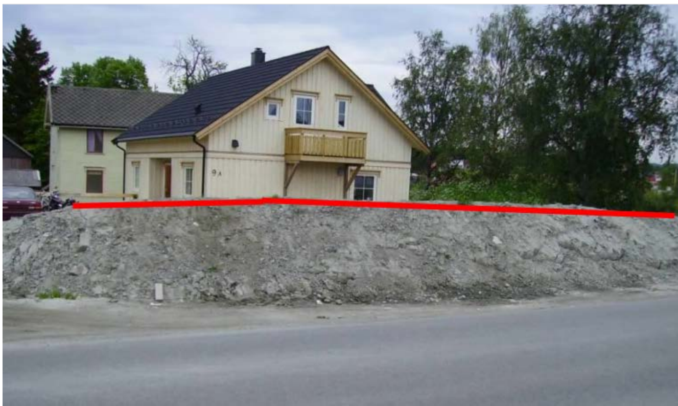
Figur 40. Eksempel på registrering av av Vull med skjermingsfunksjon Støyskjerm
