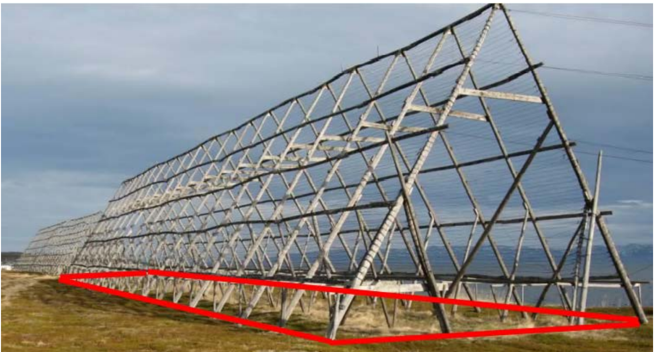
Figur 67. Registrering av ytterkant av Fiskehjell med møne (HREF = FOT)
