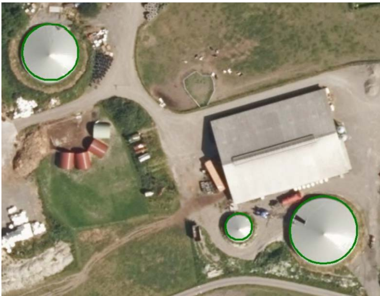
Figur 27. Eksempel på registrering av lukket gjødselkum (med tak) som MurFrittstående.
