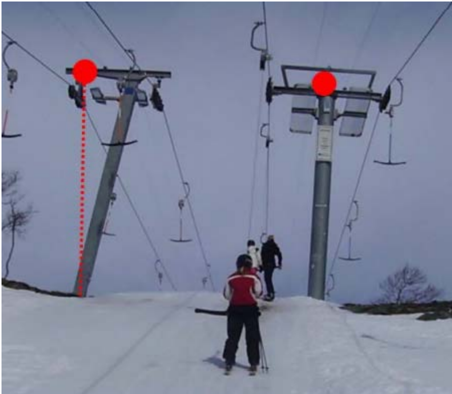
Figur 54. Eksempel på registrering av taubanemast i skitrekk
