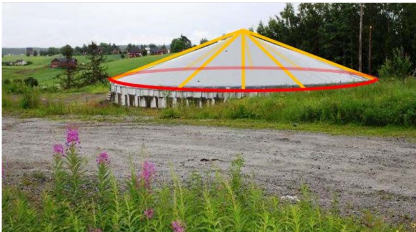
Figur 28. Eksempel på registrering av lukket gjødselkum (med tak) som MurFrittstående (rødt) og BeskrivendeHjelpelinjeAnlegg (gult)
