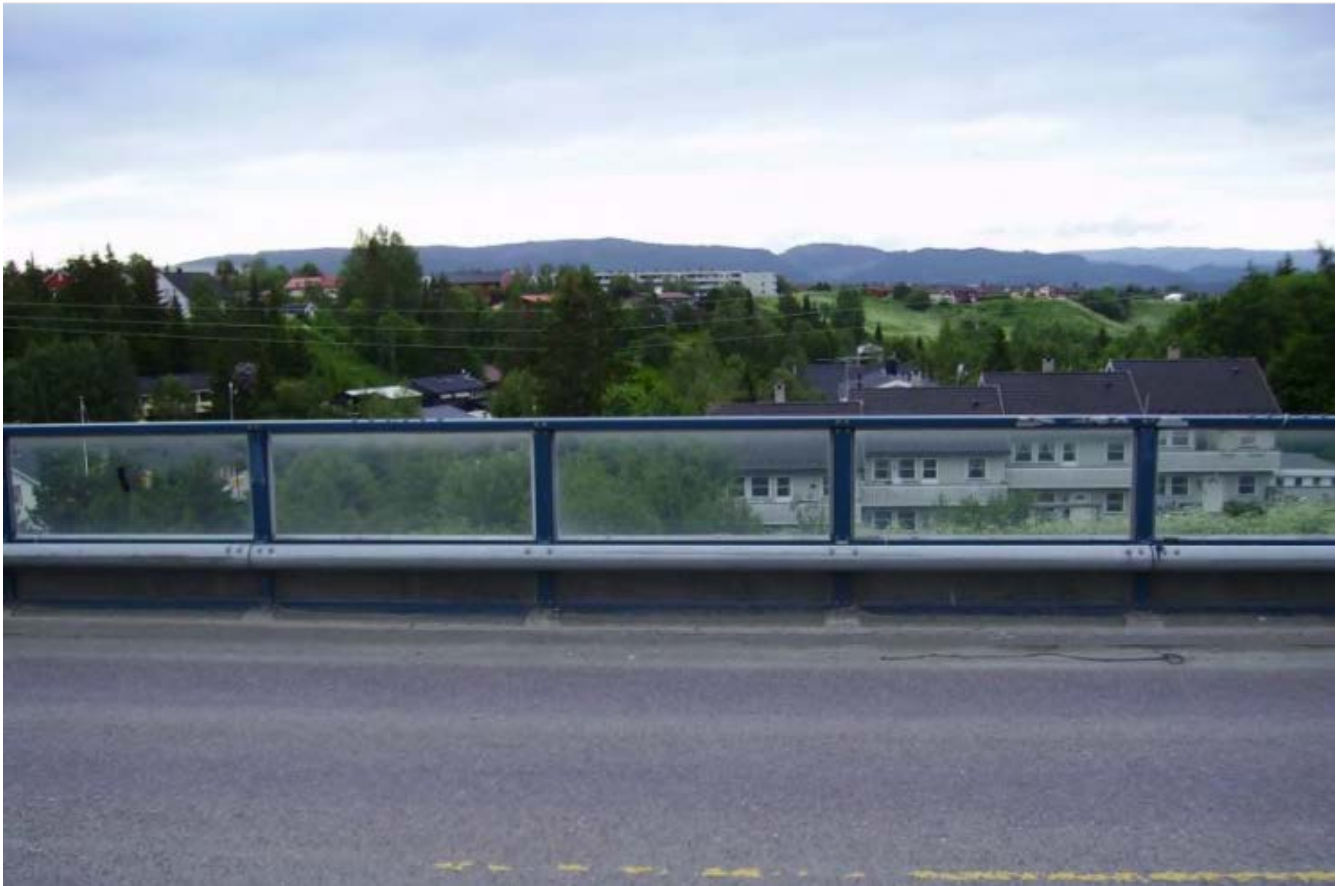
Figur 35. Innglassede skjermer skal registreres som støyskjerm.
